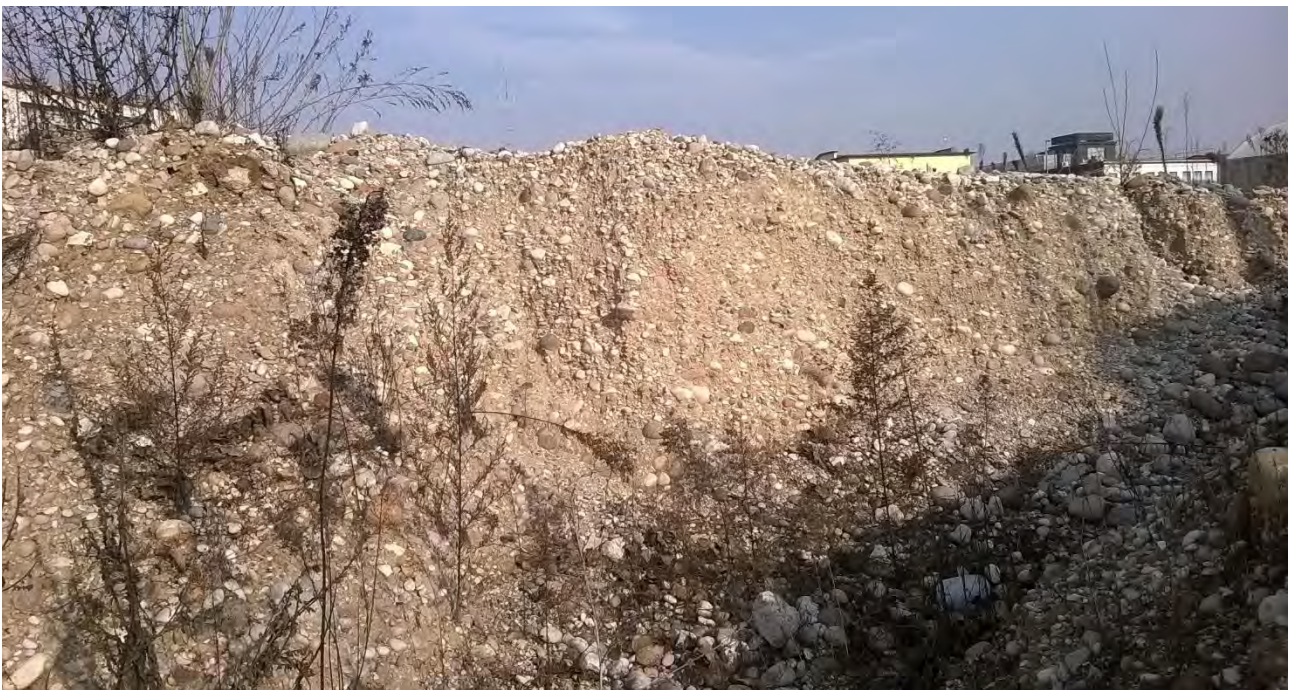
Fig. 5: fotografia di un fronte di scavo, profondo 3 m, eseguito in prossimità al confine Sud dell'area studiata, dove è stato demolito un edificio con piano interrato.
